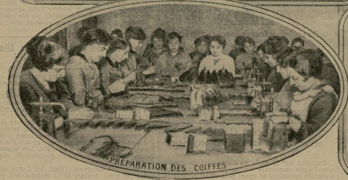
SOUDURE DES BANDES TENANT LA COIFFE ET DES ANNEAUX DE LA JUGULAIRE
