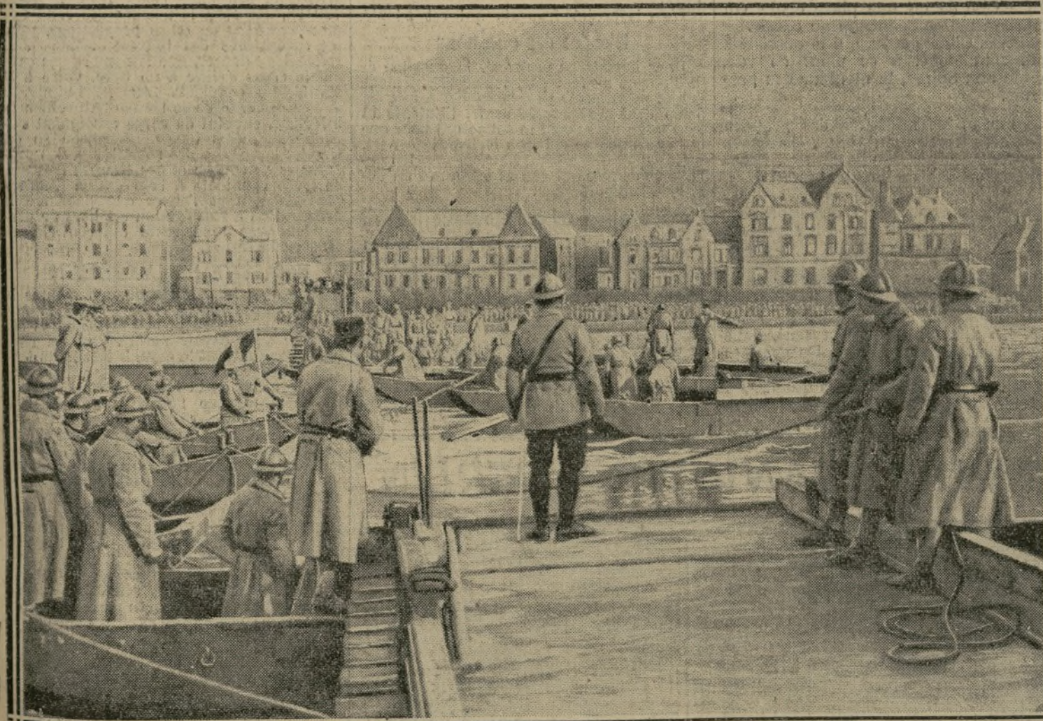
LES PONTONNIERS PROCÈDENT AU RACCORDEMENT DES DEUX AMORCES DU PONT
