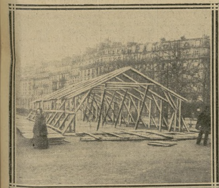
CELLE DU Bd RICHARD-LENOIR Les spécialistes de la construction des vingt-cinq premières baraques sont au travail. Elles seront achevées probablement après-demain.
