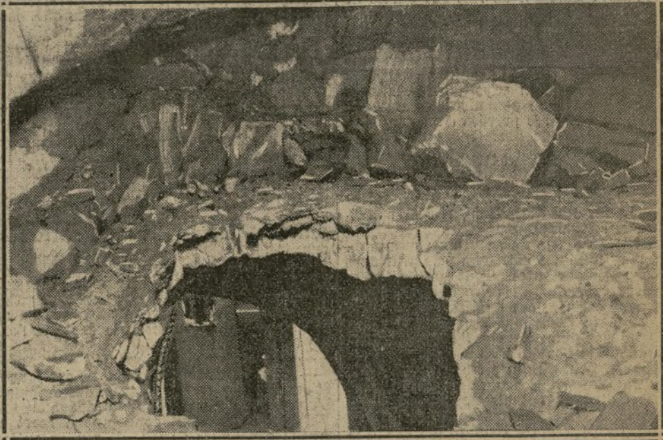
LE TROU FAIT DANS LA VOUTE PAR L'EFFONDREMENT
