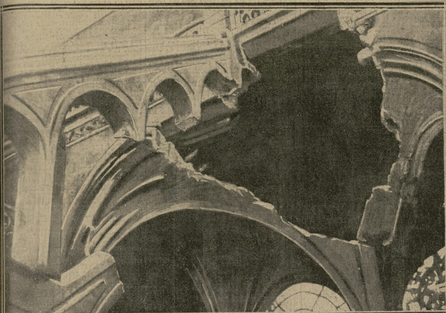
LA BRÈCHE FAITE DANS L'ARC-BOUTANT ET DANS LA VOUTE PAR L'OBUS DE 210
