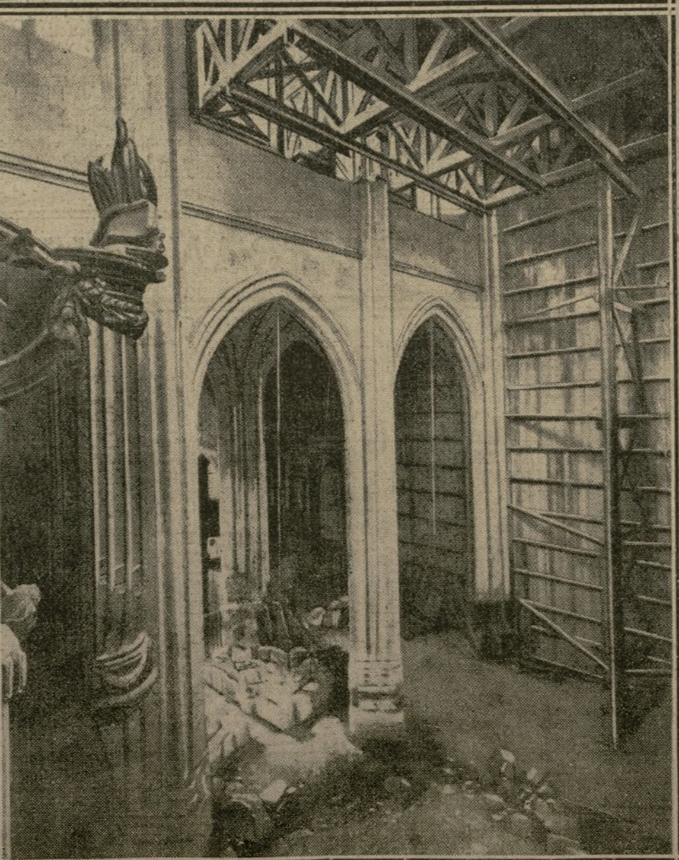
LE POINT OU S'ÉCOULÈRENT VOUTE ET ARC-BOUTANT
