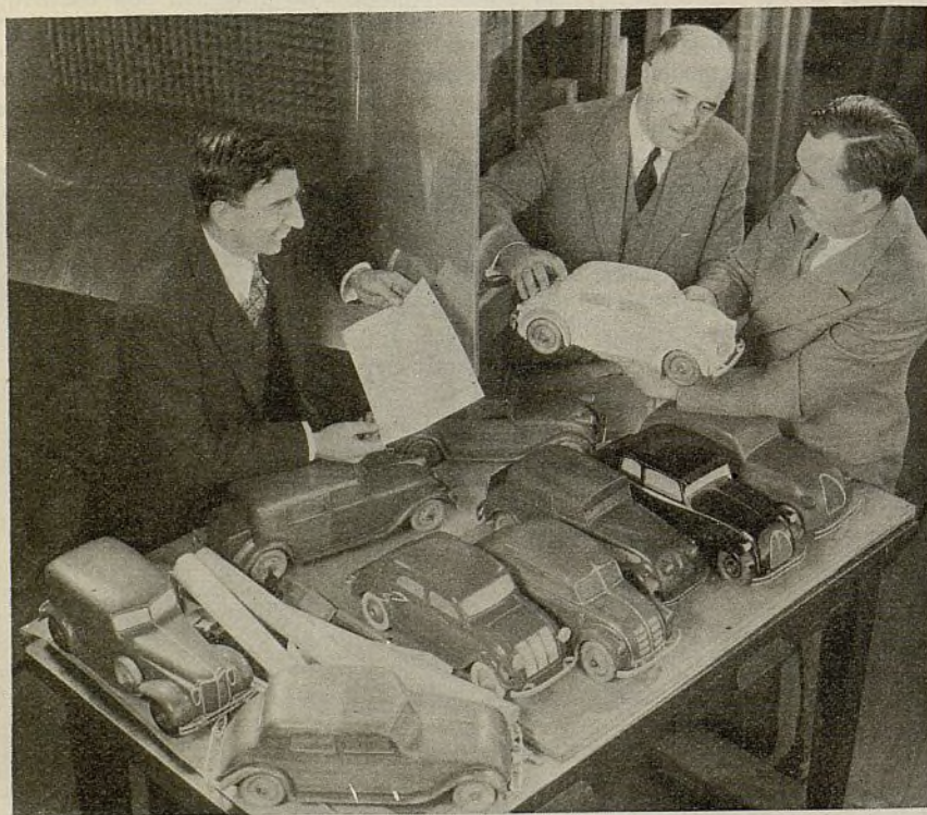
La carrocería más extraordinaria es la del nuevo DeSoto. Ella tipifica, en grado máximo, la tendencia hacia la perfilación, que caracteriza a casi todos los modelos de 1934. Mostramos aquí los ingenieros de la Chrysler y DeSoto examinando los automóviles en miniatura, después de sometidos a la prueba de túnel de viento, de los cuales se eligió uno para servir de modelo al nuevo DeSoto de 1934. El túnel de viento se ve al fondo.
