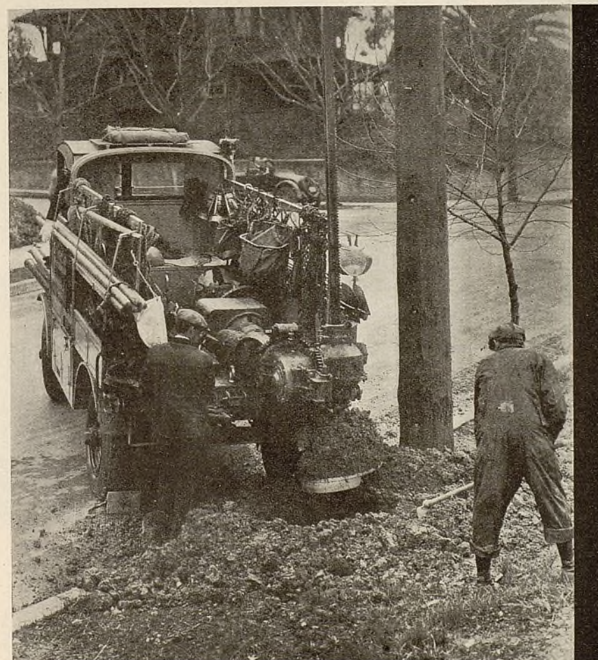
Con la fuerza mecánica de un camión, se perfora un agujero en el suelo en una fracción del tiempo que se consume en el mismo trabajo efectuado por método manual
