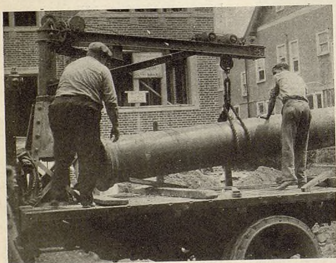
Arriba—Un camión con una grúa amovible metiendo un poste en un agujero perforado por el aditamiento perforador del mismo vehículo. Abajo—Una combinación de grúa, malacate y tróle para cargar y descargar tubos pesados
