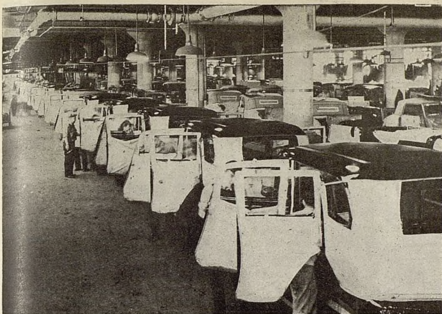
Las carrocerías del Ford V-8 se mueven en línea sin interrupción en la fábrica de la Murray Corp., de Detroit, mientras obreros especialistas dan el último toque a los detalles interiores de las guarniciones y tapicería.
