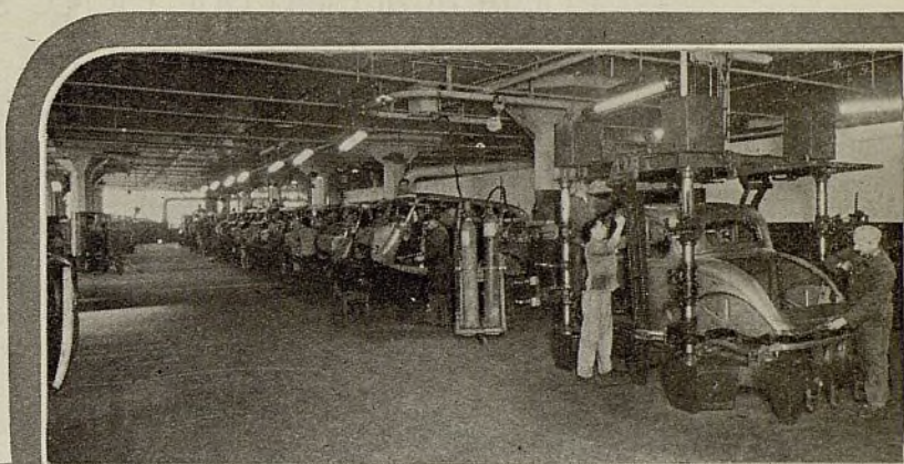
Vistas de la fábrica de la Ford Motor Company en Buenos Aires. Las vistas muestran la línea de montaje principal. Gran parte del trabajo se refiere a la instalación de carrocerías
