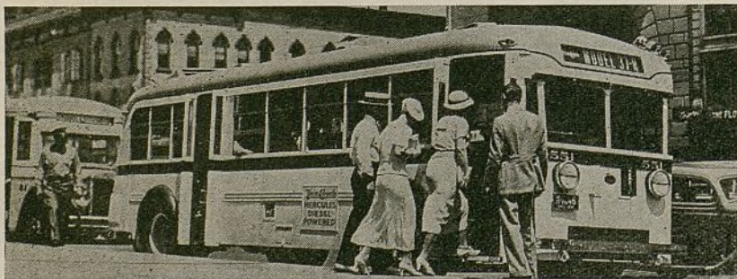
Un modelo de Twin Coach 37-R provisto de motor Hercules DRXB de tipo diésel, que se halla en servicio en la ciudad de Boston
