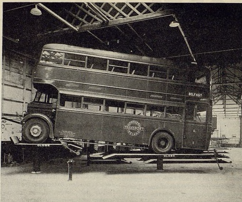
La reparación de ómnibus se facilita mucho con la ayuda de los nuevos levantadores fabricados por la Globe Machinery & Supply Co. Mostramos aquí un levantador Globe de doble émbolo instalado en el Northern Transport Garage en Belfast, el cual tiene siete de estos levantadores a su servicio
