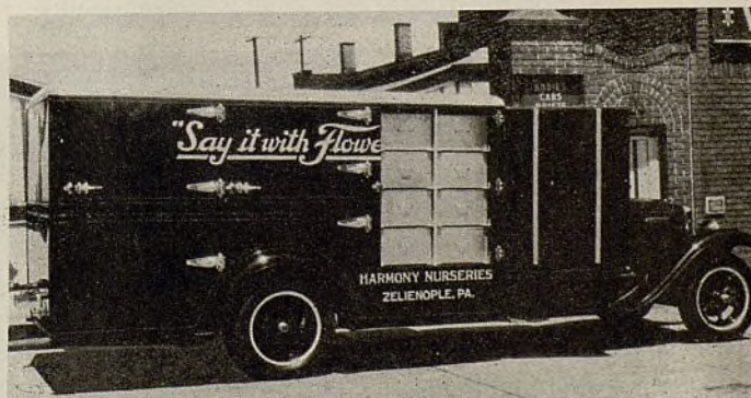
Tres compartimientos de esta carrocería, enfriados por "hielo seco" van llenos de bandejas para flores. Cuando hay necesidad de calor, se aprovecha el proveniente del escape. Las flores se protegen en papel de celofane y se entregan siempre frescas al comprador.
