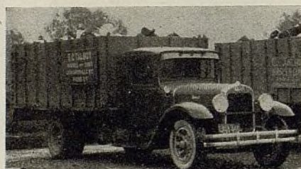
Esta fotografías muestran dos aplicaciones típicas de la carrocería de teleros o varales, al servicio de la agricultura. La vista de arriba muestra el camión dispuesto al transporte de granos. La de abajo lo presenta dispuesto al transporte de ganado.
