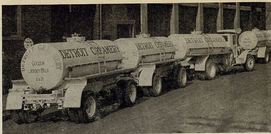
Camiones y remolques provistos de tanque. Se utilizan en numerosos negocios. Los que mostramos aquí llevan interior de vidrio y se emplean para la recolección y reparto de leche. Hay tanques de acero, de acero inoxidable y de otros materiales, para el transporte de sustancias químicas y otros líquidos.
