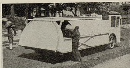
Camión de tipo especial para la recolección de basura, con propulsión por las ruedas aplanadoras y carrocería baja para facilitar el trabajo.
