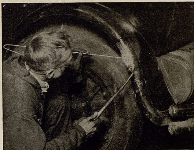
Arriba—Soldadura del reborde partido de un guardabarros. Abajo—Esmerilado mediante una lijadora mecánica, a continuación de la soldadura.
