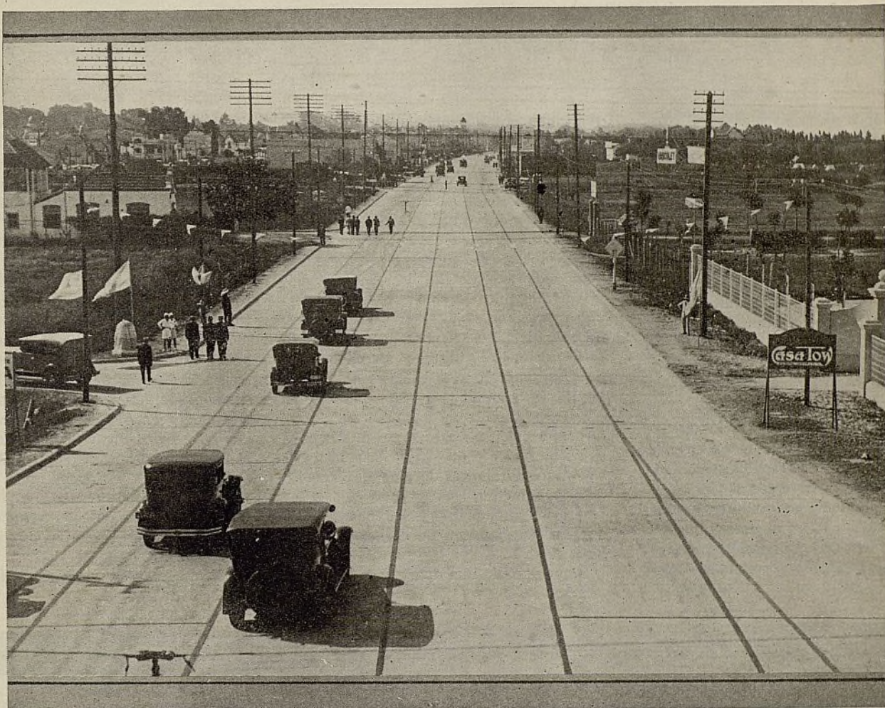
La pavimentación de calles y carreteras ha alcanzado gran desarrollo en la Argentina. La ilustración muestra la carretera de seis zonas, con pavimento de hormigón de cemento, construida con los productos de la contribución voluntaria de la gasolina. La carretera parte de Buenos Aires, y el tramo ilustrado es entre Rivadavia y Los Olivos
