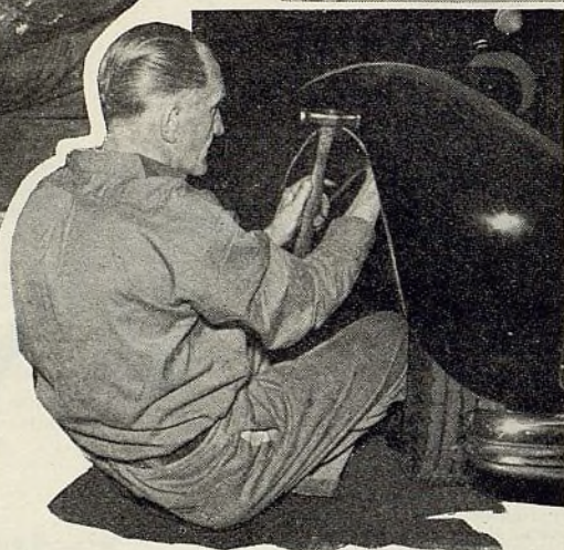
HERRAMIENTAS MANUALES . . . Aun en los talleres más grandes, que tienen martillos y otras herramientas neumáticas, hay necesidad de herramientas manuales para trabajos de carrocerías. A la derecha mostramos un martillo de guardabarros y soporte en uso, y arriba, una lima de carrocería
