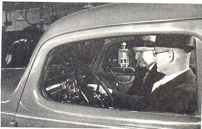
DEMOSTRADOR DE ECONOMIA . . . La Hudson está suministrando a sus agentes un medidor especial para demostrar la economía de sus modelos de 1937. El indicador no sólo acusa el número de millas que el automóvil ha recorrido con una cantidad medida de combustible, sino que da información sobre la calidad del combustible entregada por la bomba y la presión bajo la cual se realiza el funcionamiento.
