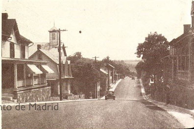
Abajo — Ensanchando este camino principal y dándole una superficie bituminosa, se evitó grandemente la congestión del tráfico. El camino tiene ahora 33 pies de anchura y hay 38 pies entre las veredas.
