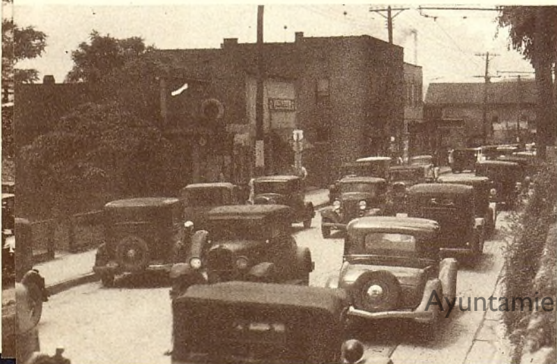
Abajo — Ensanchando este camino principal y dándole una superficie bituminosa, se evitó grandemente la congestión del tráfico. El camino tiene ahora 33 pies de anchura y hay 38 pies entre las veredas.
