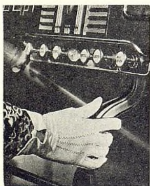
LA PALANCA DE ENFRENA-MIENTO se ha quitado del piso. La nueva palanca, con mango de pistola, sobresale por debajo del tablero.
