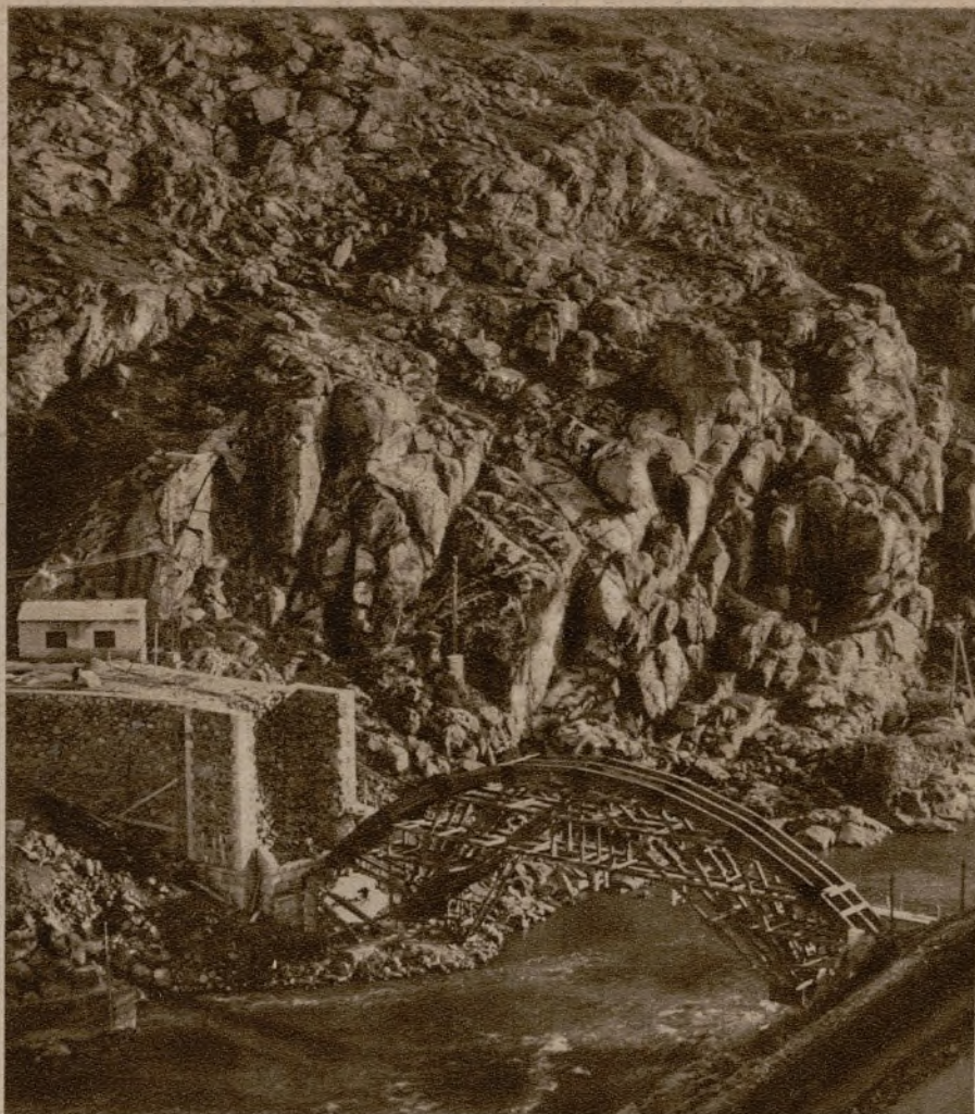
TOLEDO.—Colocación de la cimbra del puente en construcción que ha de sustituir al de Alcántara. El único arco del nuevo puente tendrá cuarenta y un metros de luz.
