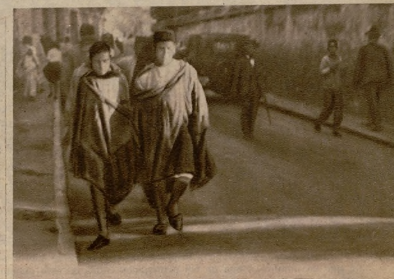
Delincuentes indigenas conducidos a la cárcel, esposados y en cuerda.
