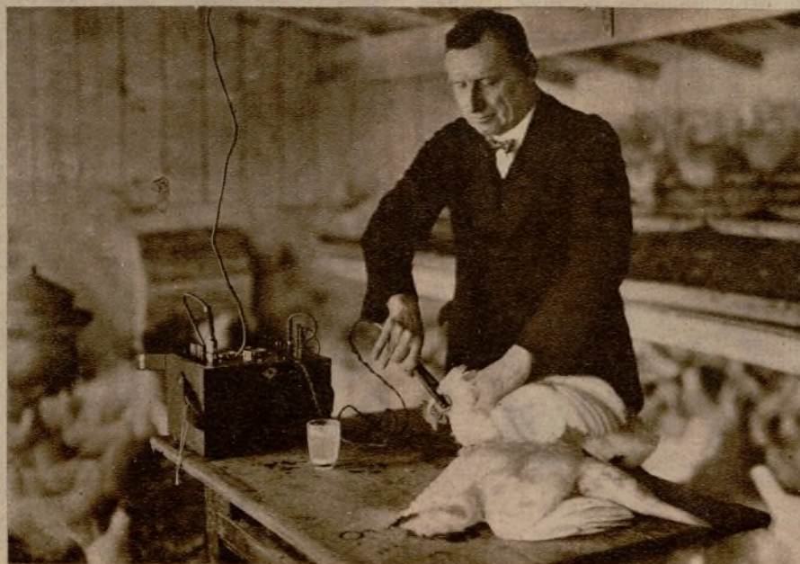
Muerte instantánea y sin dolor de gallináceas, por medio de la electricidad. Se aplican los electrodos conforme se ve en la foto. La misma costumbre se ha establecido en Munich con el ganado vacuno
