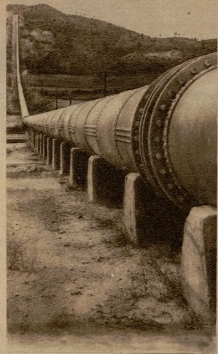
Sifón de San Vicente, obra todavía no terminada, para establecer centrales eléctricas de gran potencia
