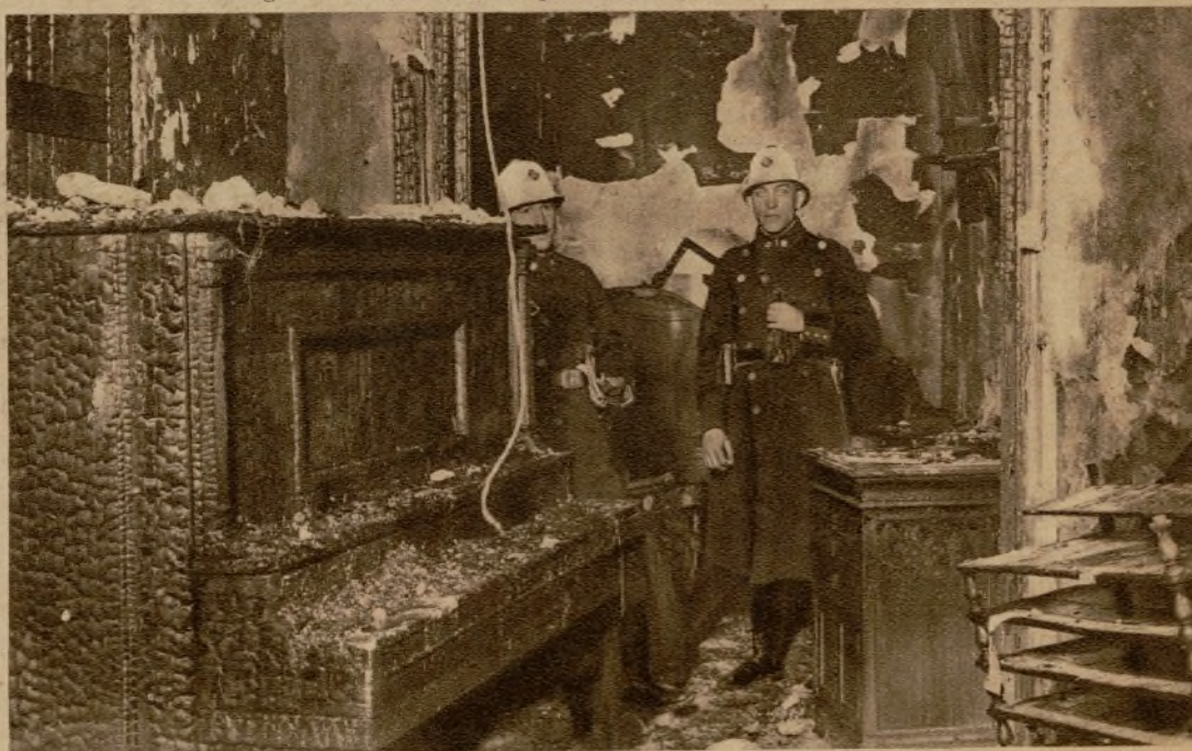
El incendio comenzó por una salamandra disimulada con una cubierta de cartón. Apenas iniciado, se propagó a una pianola, y rápidamente a los demás muebles de la habitación
