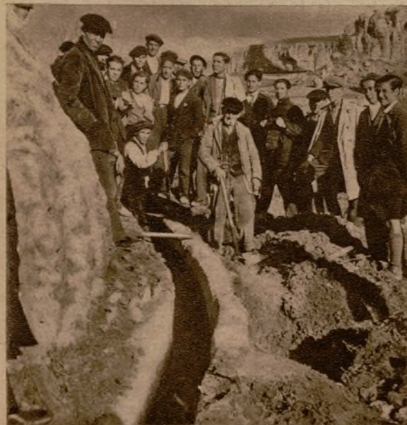
Un grupo de obreros, ocupados en la separación de la cañería de abastecimiento de aguas, que fué arrancada en un trozo de cincuenta metros por el bloque despeñado
