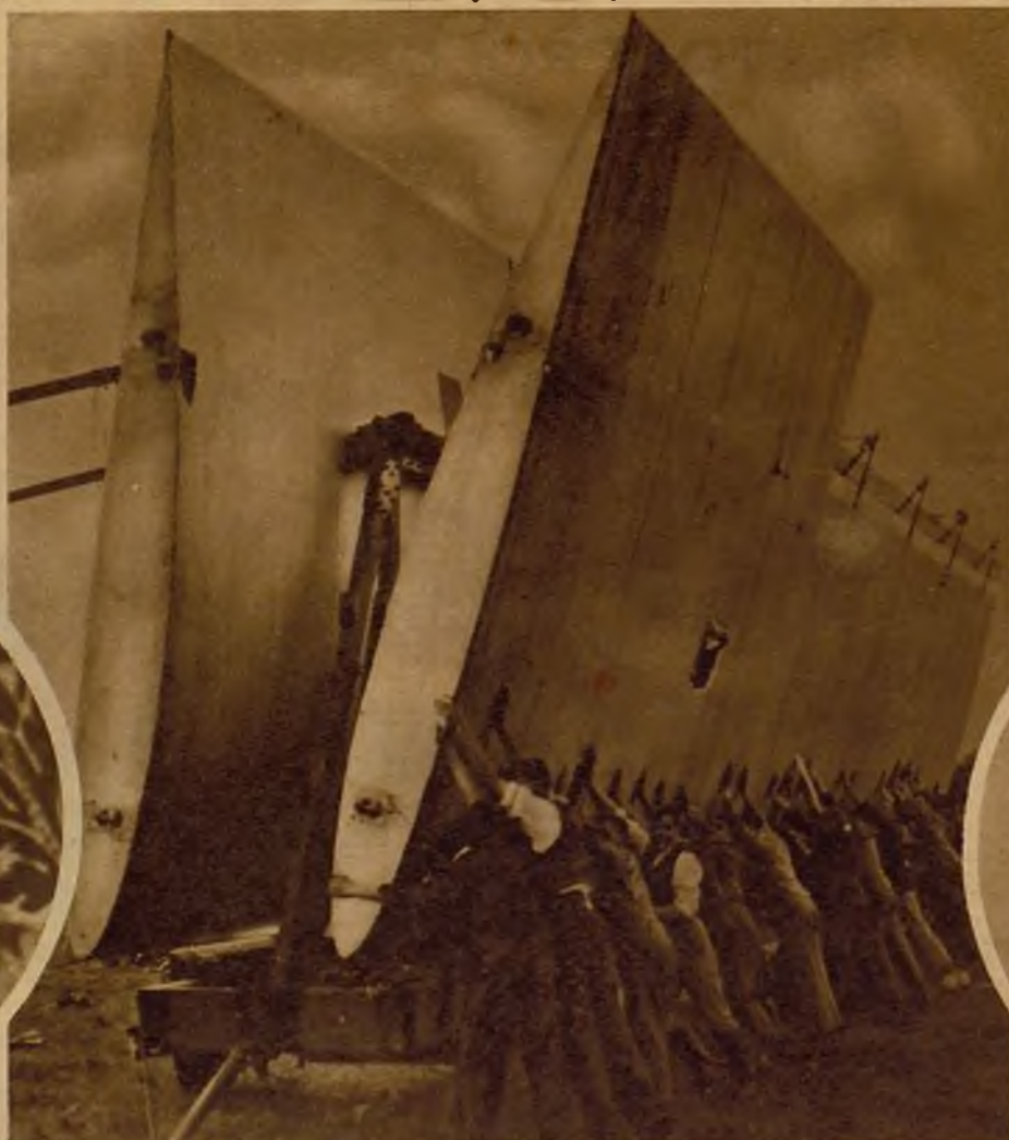
Obreros colocando sobre una plataforma las alas del gigantesco avión comercial americano "The Hannibal", averiadas en un aterrizaje torzoso (Foto Contreras y Villaseca)
