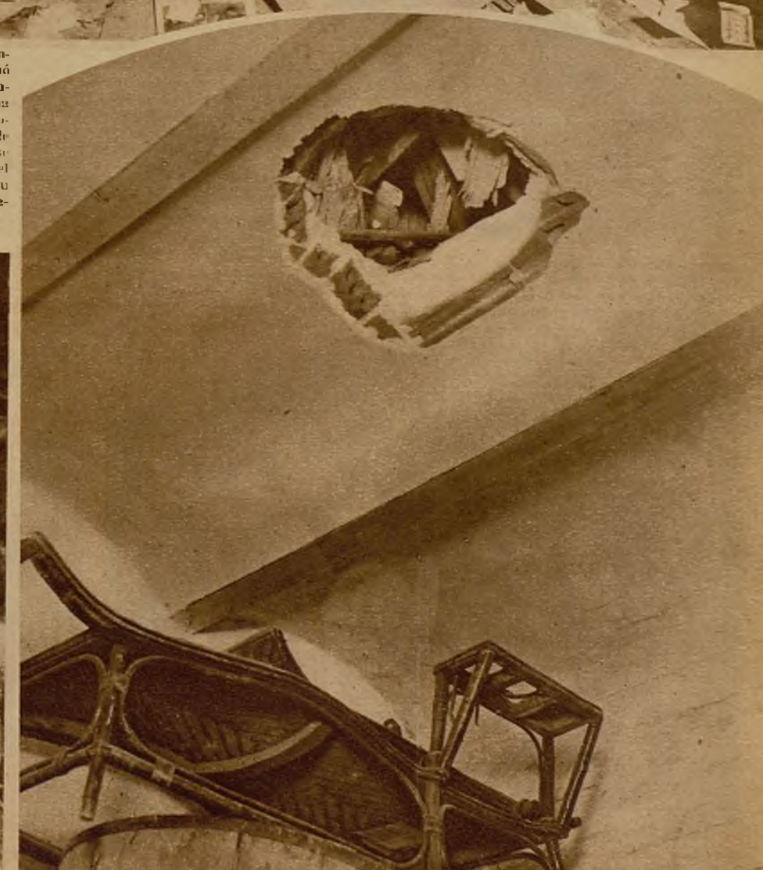
La metralla que contenía el explosivo produjo, como se ve en la foto, un gran agujero en el muro.
