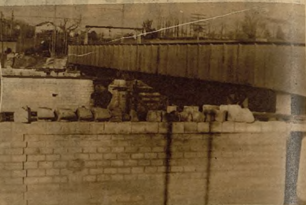
Véanse los pilares que han de soportar el puente que va a ser inaugurado solemnemente en San Sebastián. A las doce de la noche del sábado, por medio de gatos y tractores eléctricos, se efectuará el corrimiento de la mole de hierro hasta su base definitiva (Foto Hernando)
