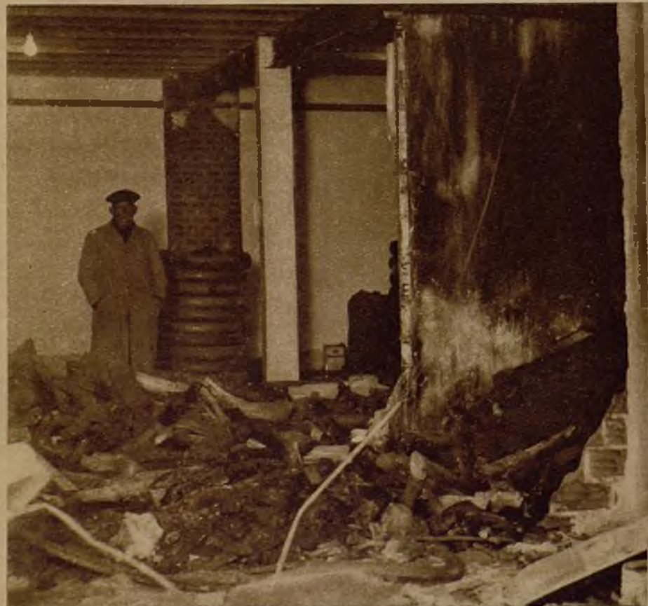
Destrozos causados en una casa de la calle de Ayala por la explosión de una caldera de calefacción. Las pérdidas originadas por el accidente ascienden a 90.000 pesetas
