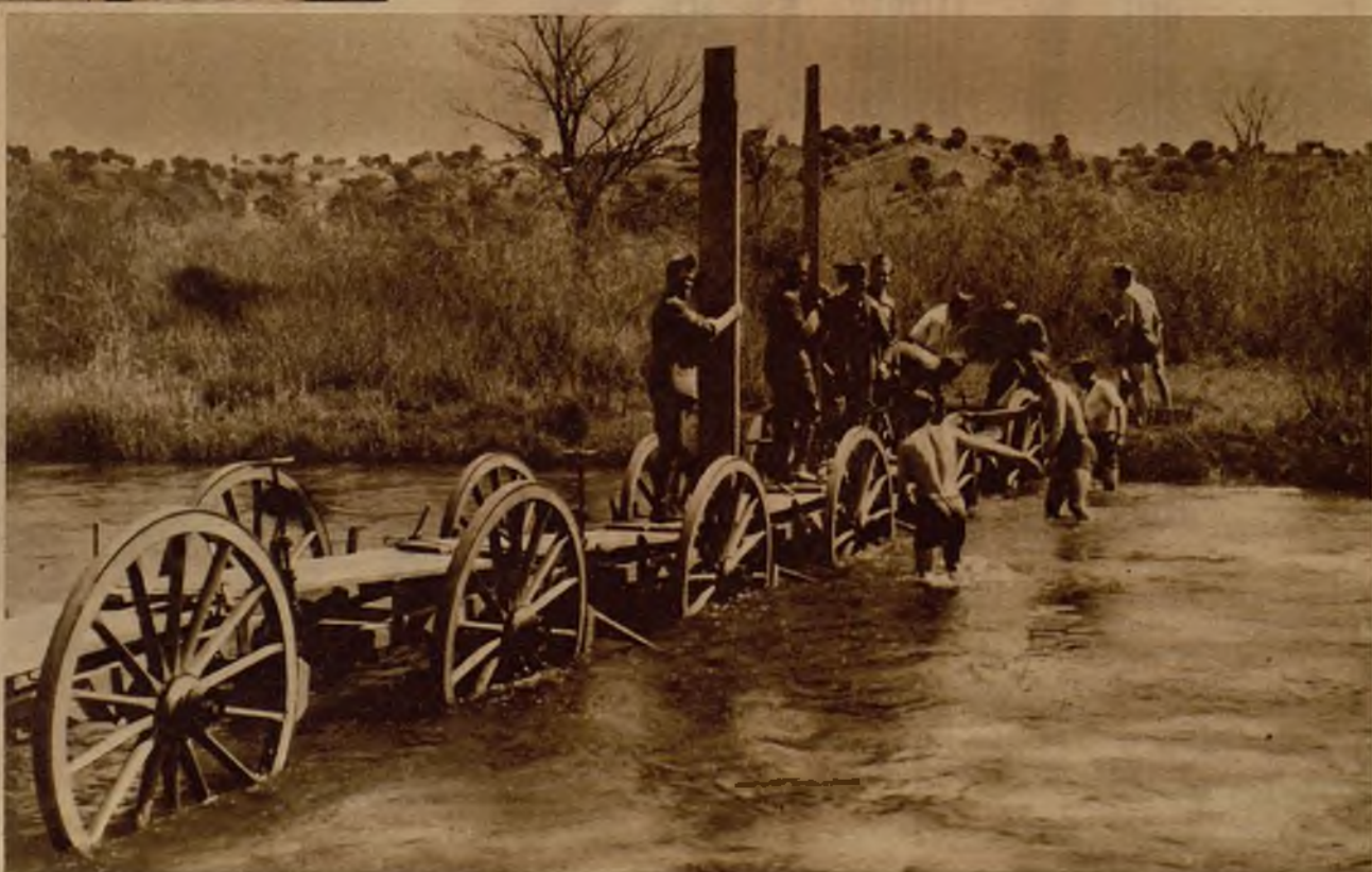
En el río Guadarrama, a la altura de Villaviciosa, se han efectuado interesantes maniobras militares por el batallón de Zapadores Minadores número 1, de la guarnición de Madrid. Una de las más notables operaciones fué la colocación de un puente. La foto reproduce la instalación de uno de los soportes
