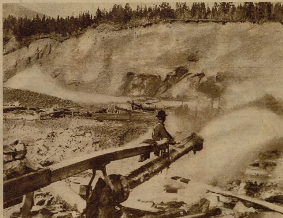
Parte del "oro inglés" procede de estas minas africanas, en las que se emplea la fuerza del agua para arrancar el cuarzo
