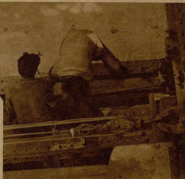
Dos obreros levantan, mediante el impulso de un "gato", la masa del puente, para introducir los patines que servirán para el corrimiento
