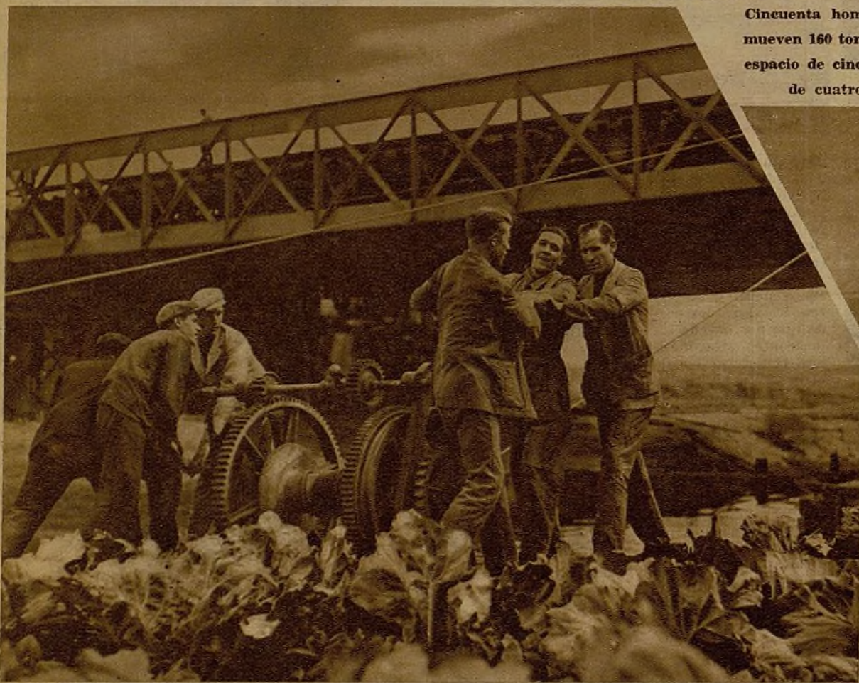
Dos obreros levantan, mediante el impulso de un "gato", la masa del puente, para introducir los patines que servirán para el corrimiento
