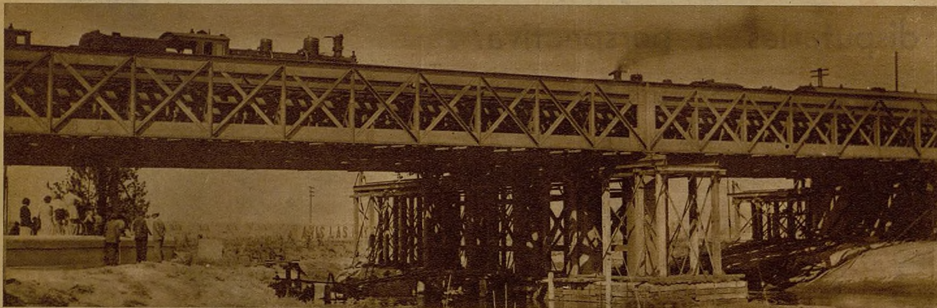
Cincuenta hombres, con ayuda de una maquinaria de simple factura, mueven 160 toneladas—esta enorme masa de hierro de un puente—en un espacio de cinco metros, en menos de una hora. Ha sido el corrimiento de cuatro puentes del ferrocarril en Villanueva de Córdoba
