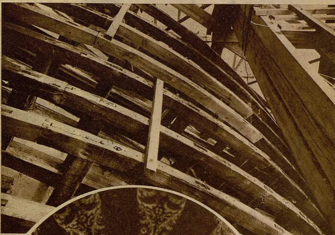
Un aspecto de la bóveda de la iglesia de San Andrés, joya del arte barroco del siglo XVII, declarada monumento nacional. En la foto se observan los refuerzos de madera y cemento que han sido urgentemente colocados para evitar el derrumbamiento
