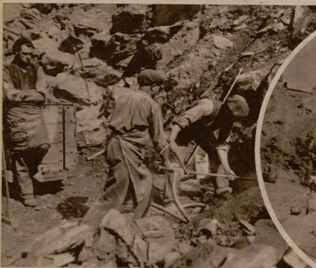
Los mineros perforan la roca por medio del barreno automático, que la hará saltar en pedazos
