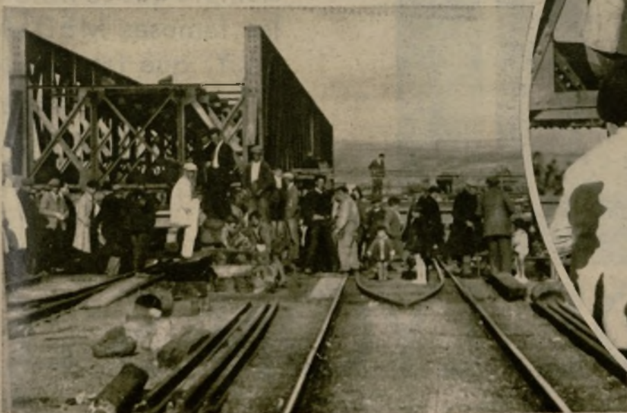
Preparando el corrimiento, por elevación, de un puente metálico de 120 toneladas de peso, sobre otros tres. La operación se ha realizado, en Villaverde por el servicio técnico de Ingenieros de Vías y Obras (Fotos Contreras y Villaseca)
