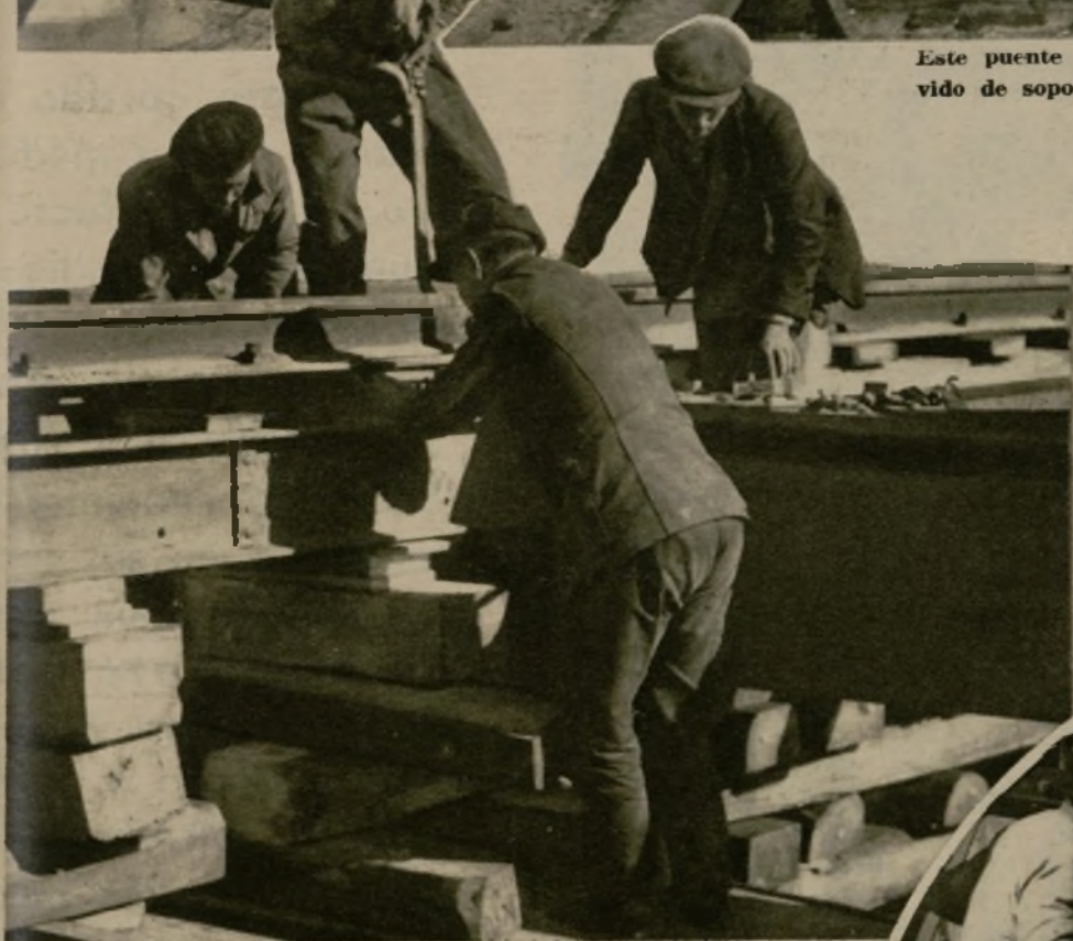
Para efectuar la sorprendente operación estos obreros colocan los carriles sobre los que ha de deslizarse el puente
