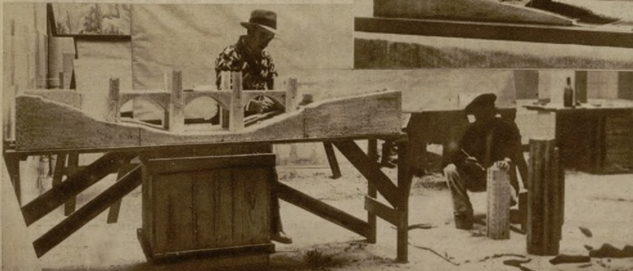
Obreros trabajando en la construcción de la maqueta de uno de los interesantes proyectos que figuran en el concurso convocado por el Ayuntamiento madrileño para la construcción del nuevo viaducto sobre la calle de Segovia (Foto Llompart)
