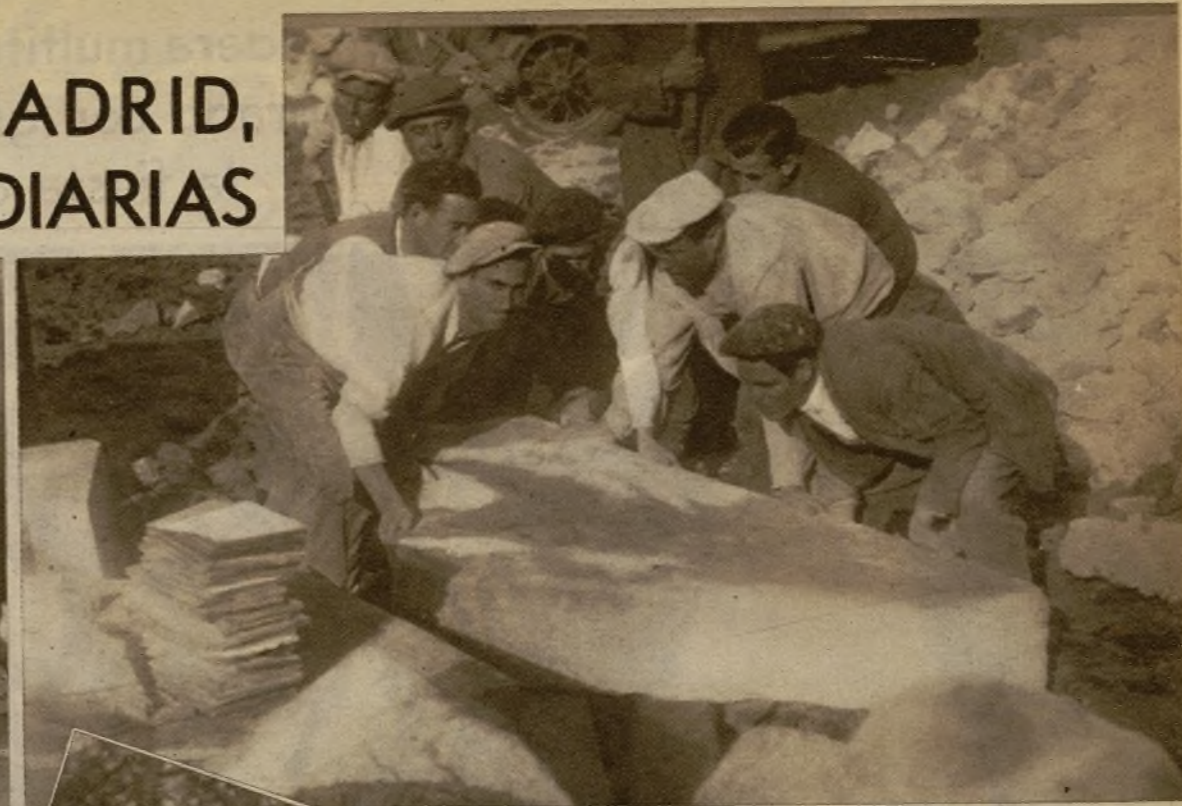
Madrid emplea varios miles de obreros en la reparación de sus parques, de sus calles, y todos trabajan con el ahínco que puede verse en la adjunta fotografía (Fotos Palomo)
