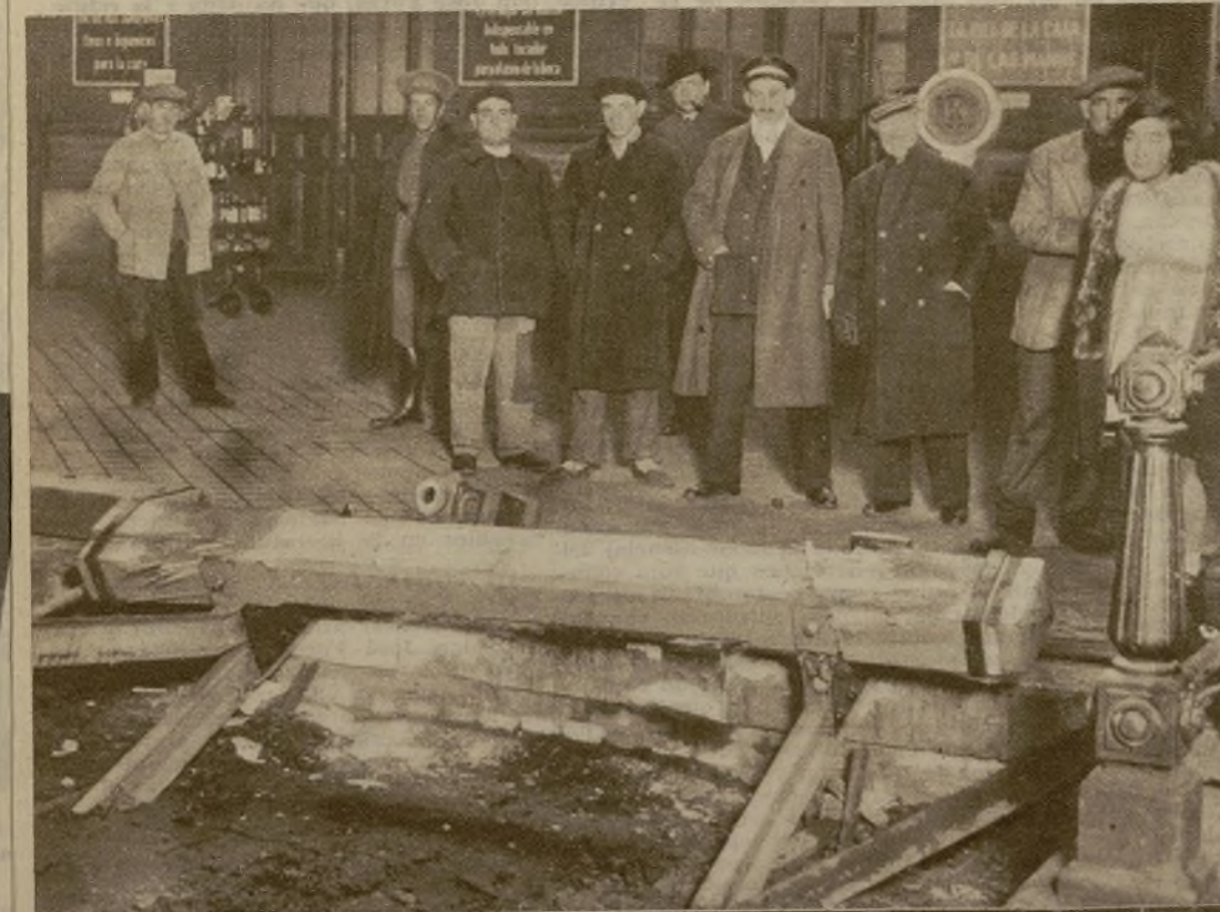
Estado en que quedaron los topes del andén de la estación de Atocha, contra los que chocó la máquina de un tren de viajeros, cuyos frenos no funcionaron debidamente. Por fortuna, no ocurrieron desgracias personales a consecuencia del accidente
