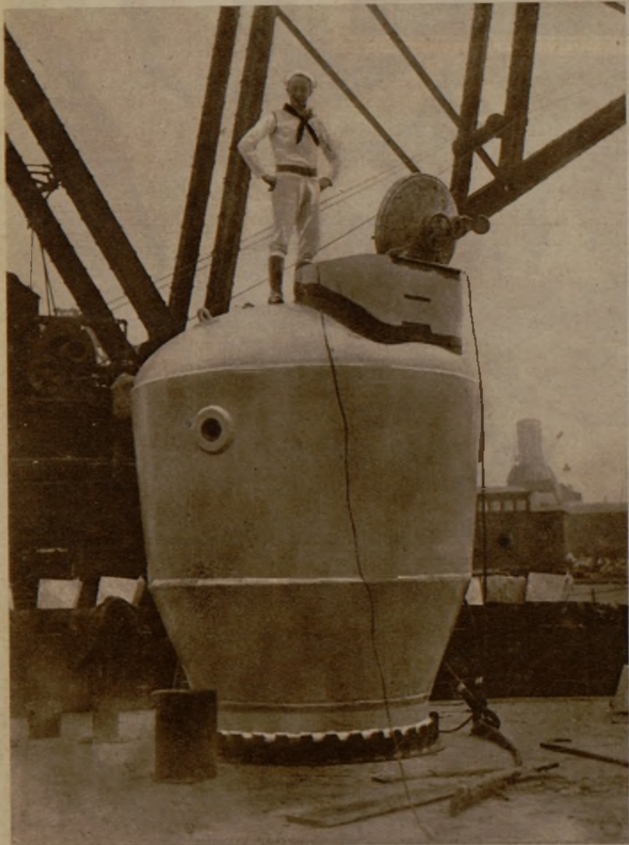
En Nueva York ha sido probado con gran éxito este aparato para realizar los salvamentos en caso de hundimiento de un submarino. Caben en él varios hombres, y puede ascender y descender por sí solo. Tiene cámara de aire, teléfono y otros servicios necesarios
