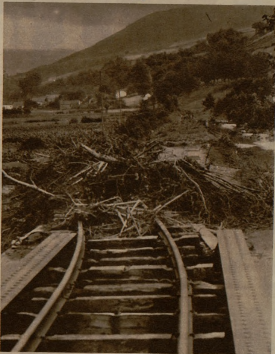
La invasión de las aguas en San Vicente de Toranzo produjo los destrozos que pueden apreciarse en la fotografía en los raíles del ferrocarril que cruza sobre el río
