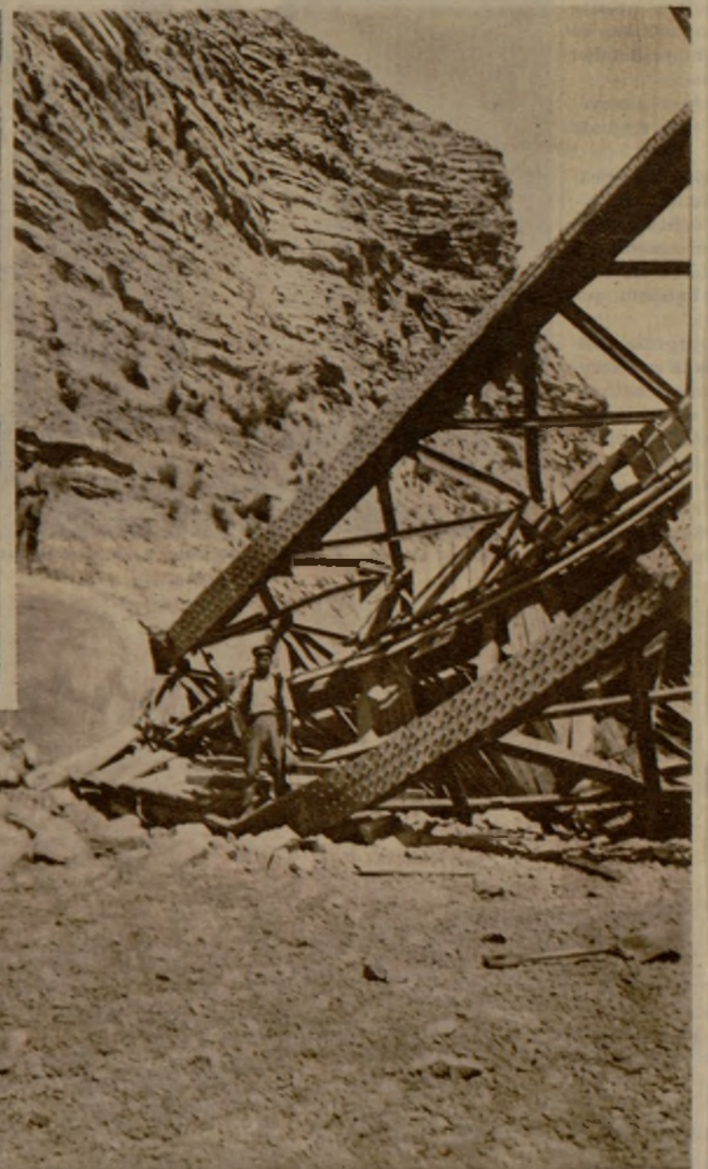
Otra muestra del gran destrozo que causó en el puente de la línea de M. Z. A., entre Nonaspe y Fayón, el bloque despeñado. En la foto, a la izquierda, puede verse un trozo de la enorme mole de piedra
