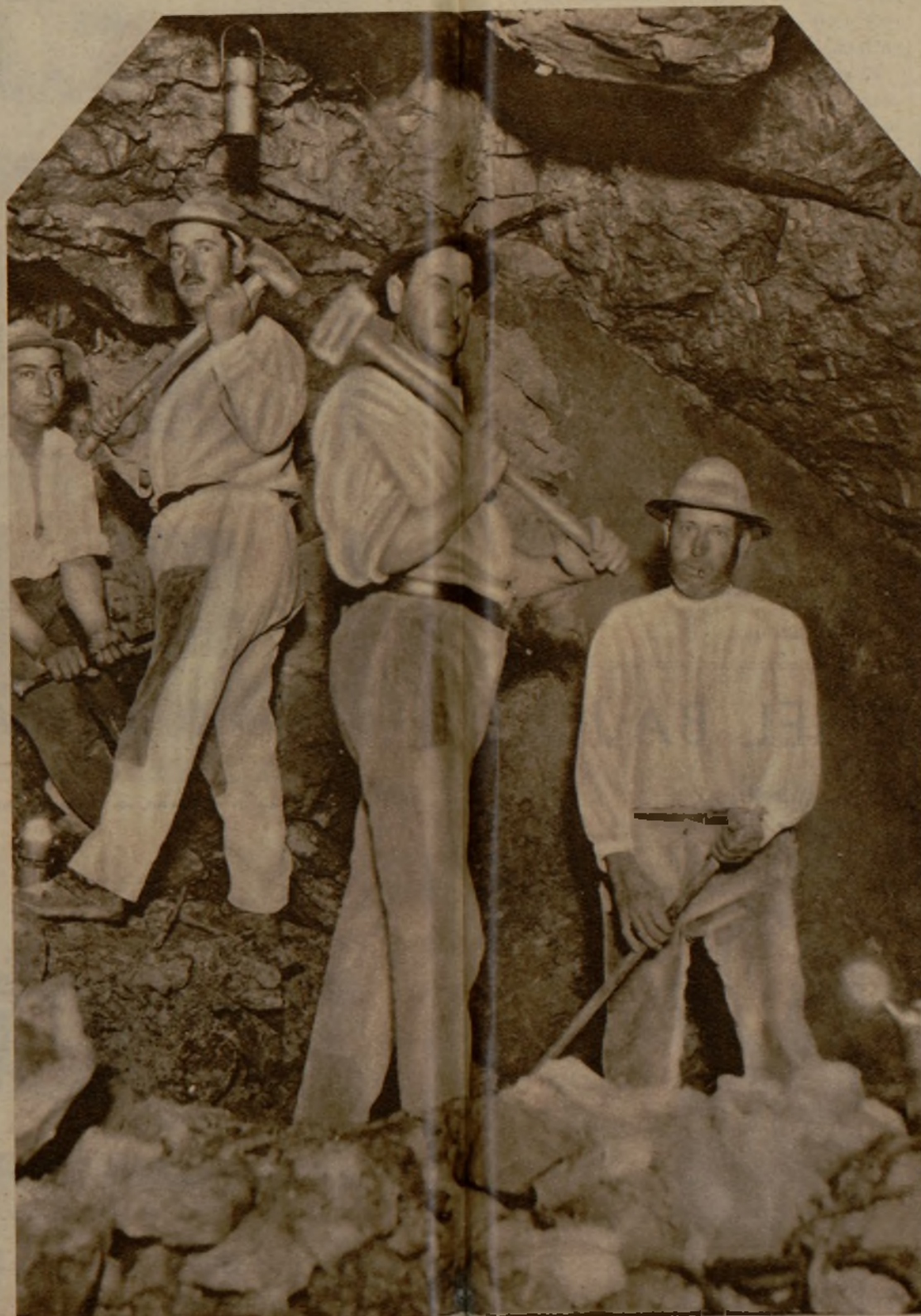
Grupo de barreneros perforando el mineral a maza, por el sitio más propenso a desprendimientos (Foto Barrera)
