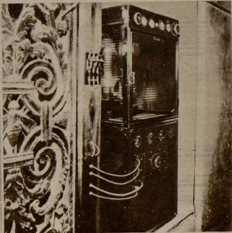
El amplificador de 600 W. que suministra la energía para toda la instalación
