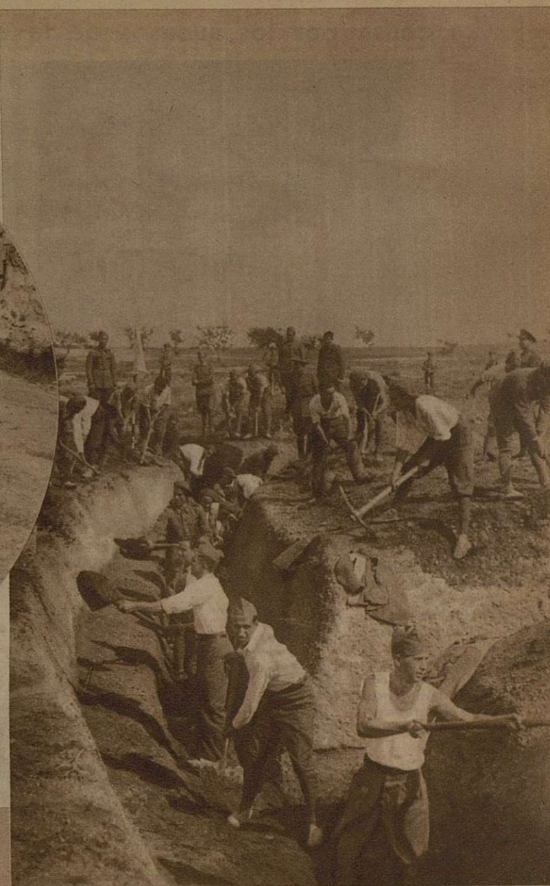
Una trinchera con pozos de abrigo, construida en pocas horas por los soldados, durante las maniobras de Manuel (Foto Lázaro)
