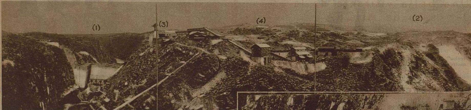
Construcción del primer salto, en el río Esla. La presa (1) permitirá embalsar 1.100 millones de metros cúbicos de agua. Los materiales de que se construye proceden de la cantera (2), y el hormigón se fabrica en (3). Al fondo (4), el poblado obrero
