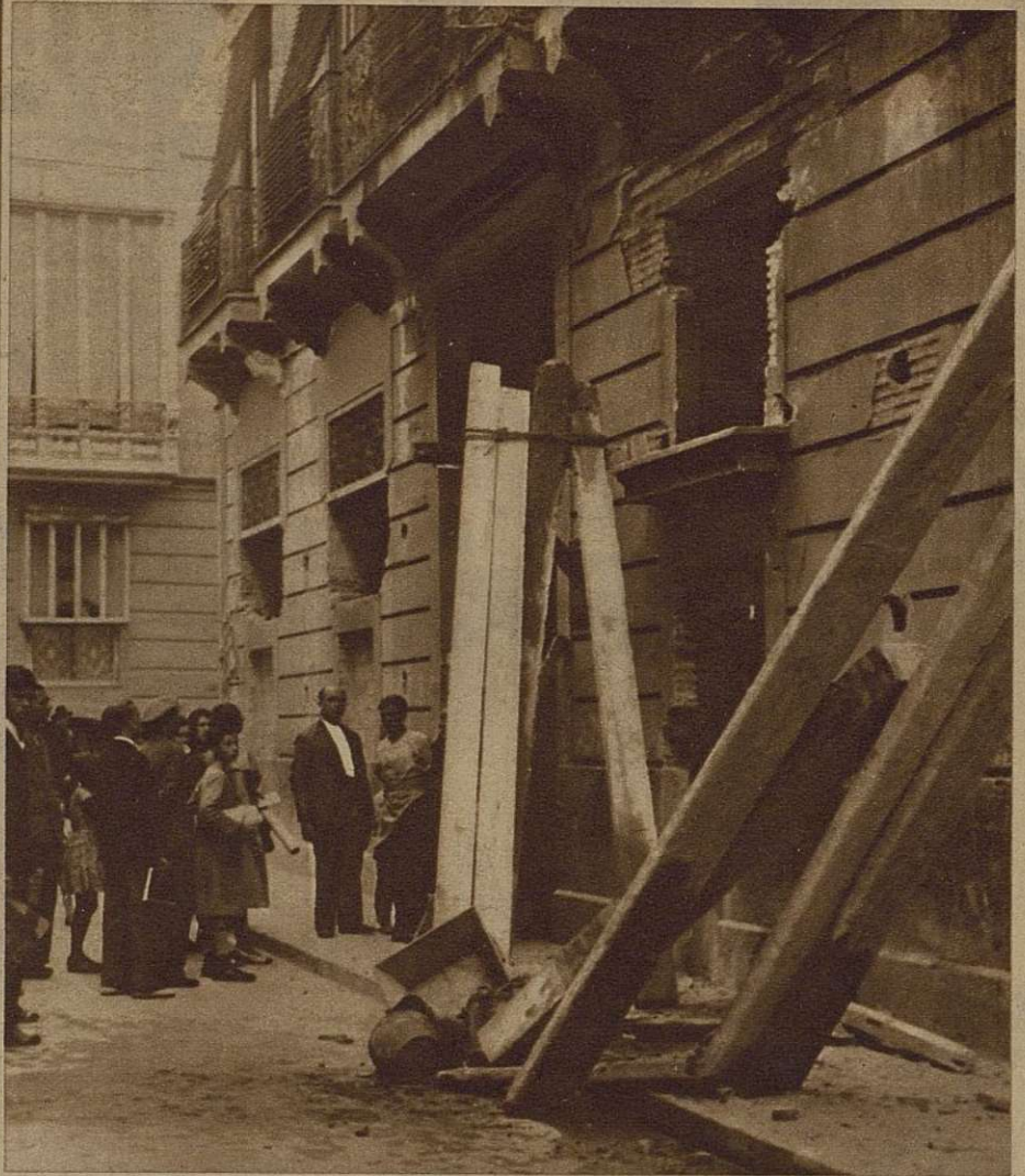
En una obra de la calle de Ruiz Lloriz, de Valencia, se desplomó un andamio, causando heridas a tres obreros. Aspecto del andamio después del hundimiento (Foto Lázaro)
