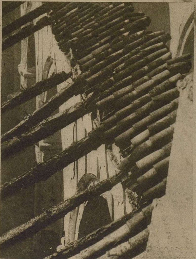
La armadura de la techumbre fué pasto de las llamas, que sólo han dejado de la iglesia el embovedado del altar mayor y los muros y columnas
