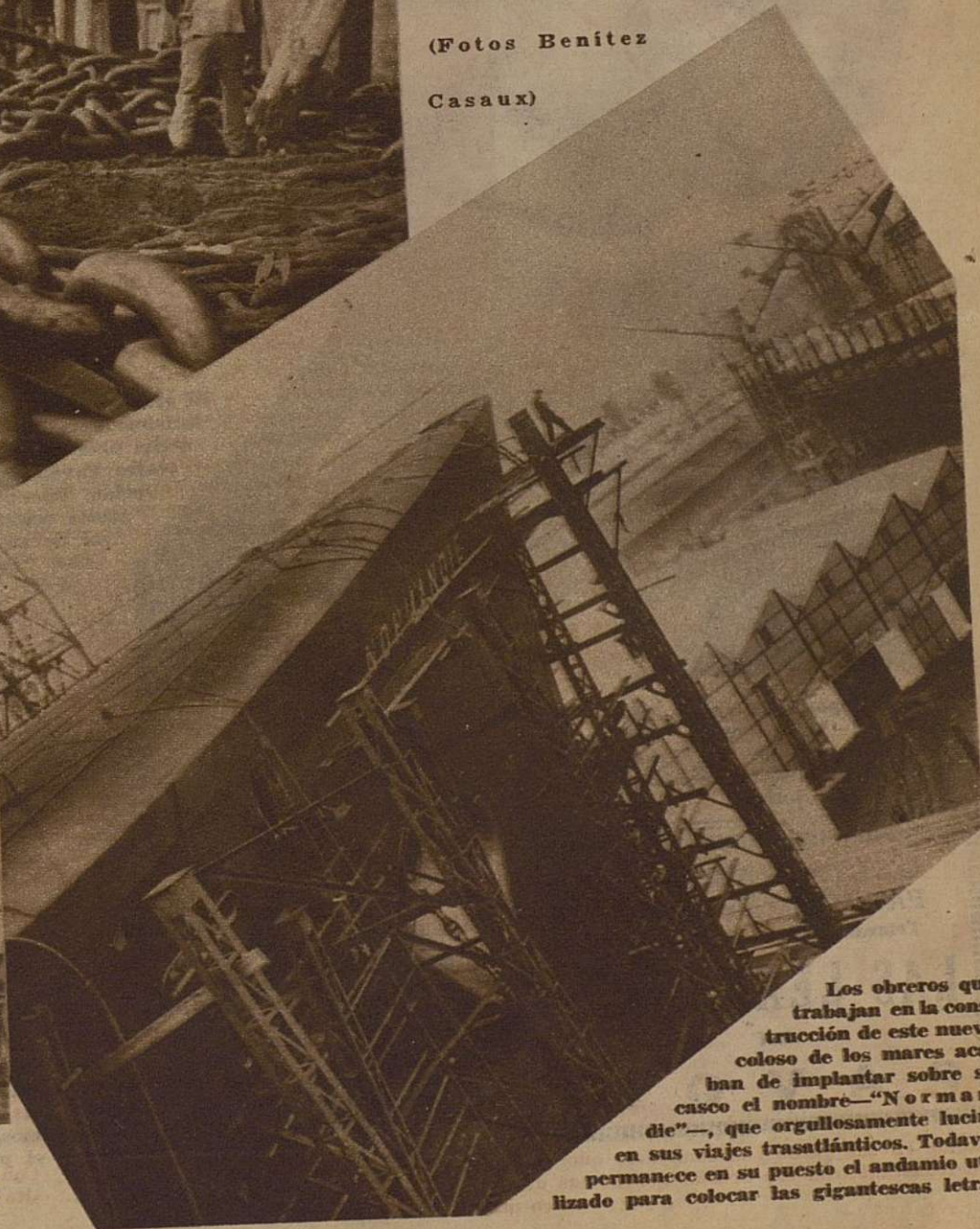
Al fondo de la fotografía aparece siluetada la enorme masa del "Normandie", cuyo desplazamiento será de 75.000 toneladas. Junto a ella se dibujan los finos esqueletos metálicos de las ocho grúas empleadas en los trabajos de construcción del buque
