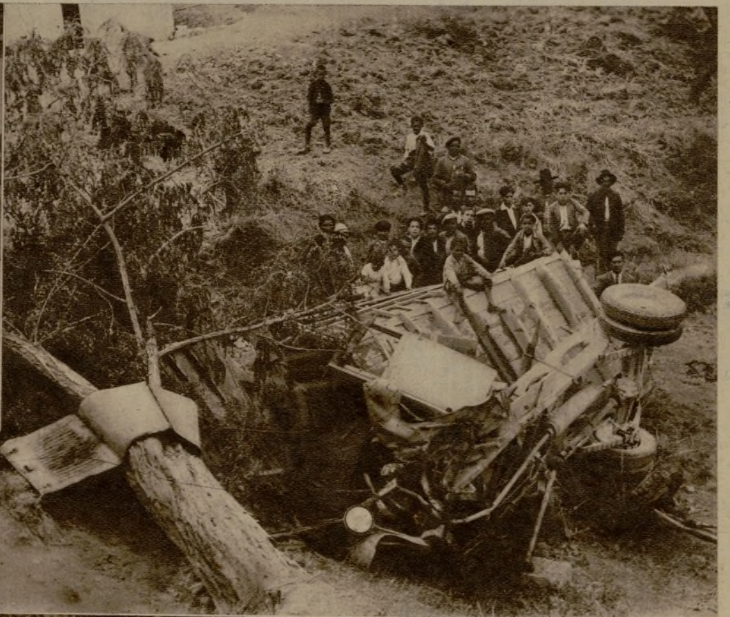
En el kilómetro 32 de la carretera de Monturque a Alcalá la Real, y a causa de habérsele roto la dirección, volcó la camioneta de transporte de la matrícula de Jaén que hacía servicio de mercancías, resultando gravemente heridos el chofer y su ayudante. El vehículo junto al árbol contra el que fué a chocar (Foto Angel)
