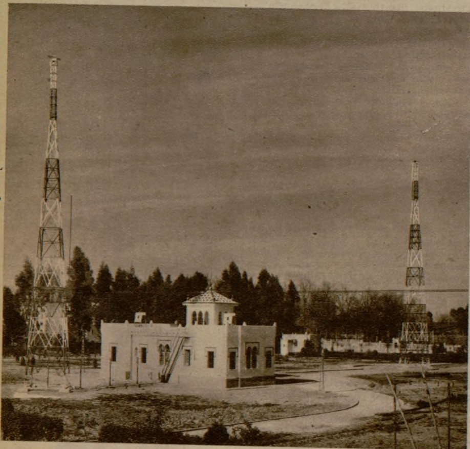
La emisora del aeródromo de Tablada (Sevilla). Nótese que los mástiles están pintados de blanco y negro para aviso de los aviones
