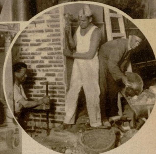
Estos obreros están practicando sitio suficiente para el paso de los tubos de agua y radiadores (Fotos Mari-Nieves)
