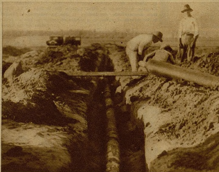
La tubería conductora de gas desde el almacén de las botellas de hidrógeno al poste de amarre
