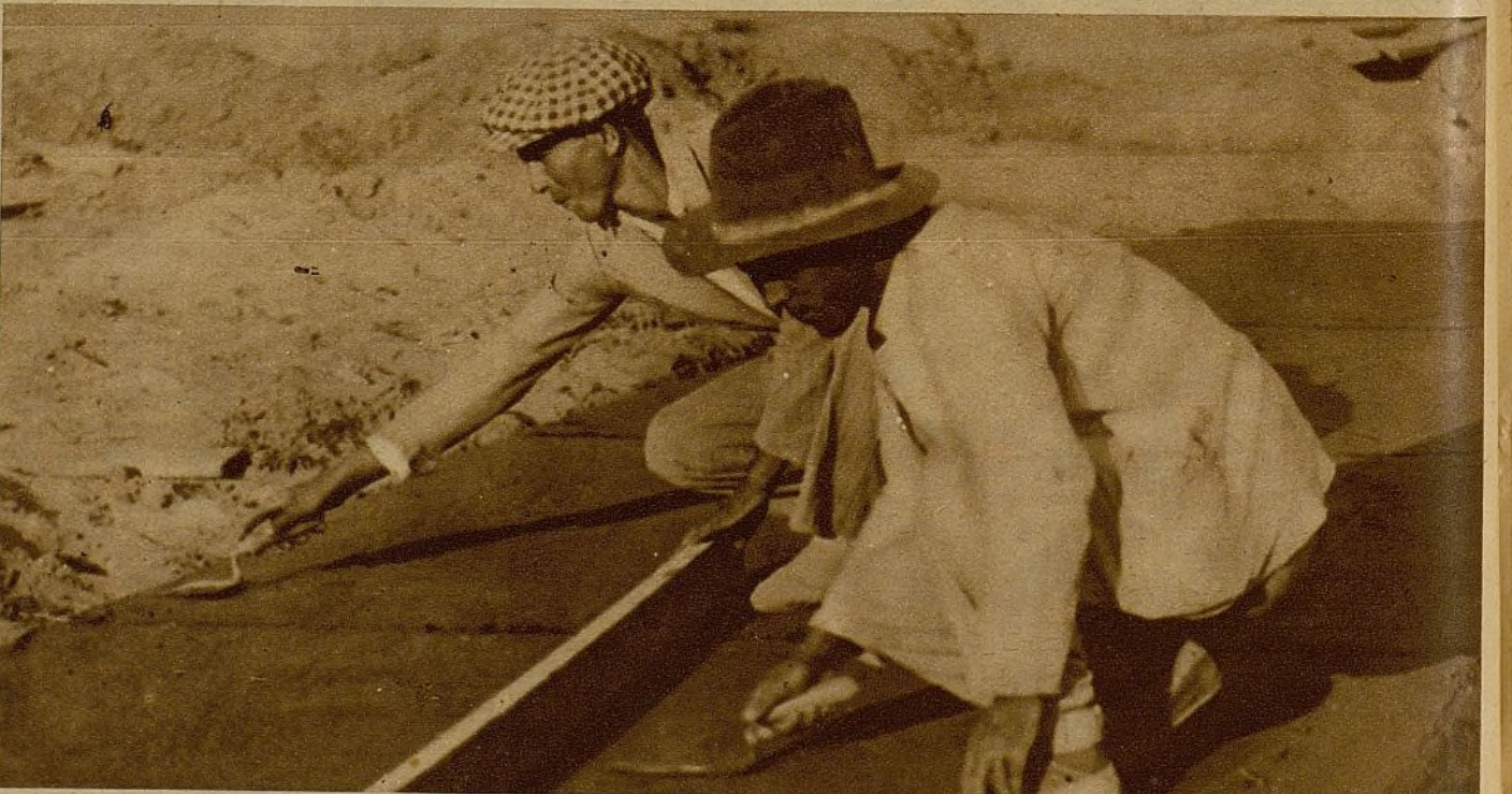
Los obreros terminan con el tendido de cemento el andén circular para apeadero y embarque de viajeros (Fotos Gonsanhi)
