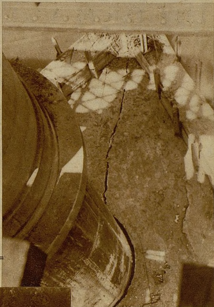
Uno de los pilares del puente que se desplazó por efecto de la explosión. En el suelo se produjo una gran grieta, por lo que será necesario reparar la cimentación
